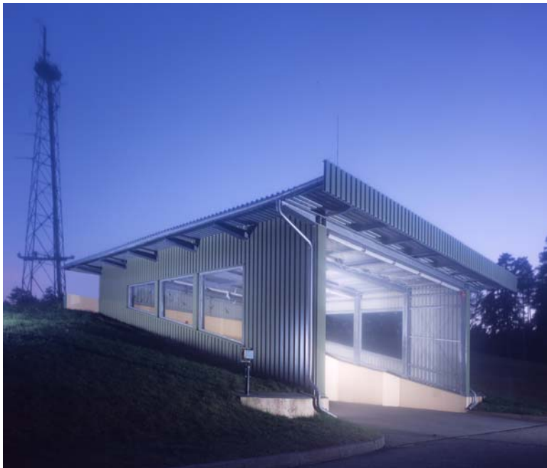
Überwachter Eingangsbereich zum Datacenter
