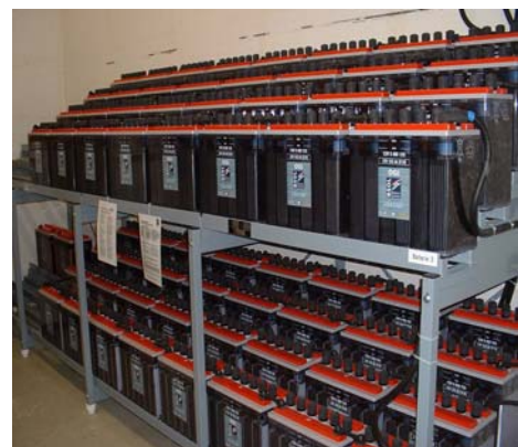
Bleibatterien Typ: OGi mit einer Lebensdauer < 12Jahre
