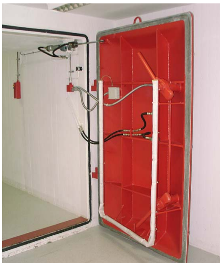
Eingangstür zum Bunker
